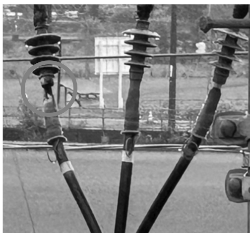
事故点：高圧引込みケーブル
