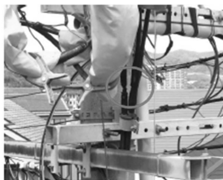
写真2 事故ケーブルの設置状況
