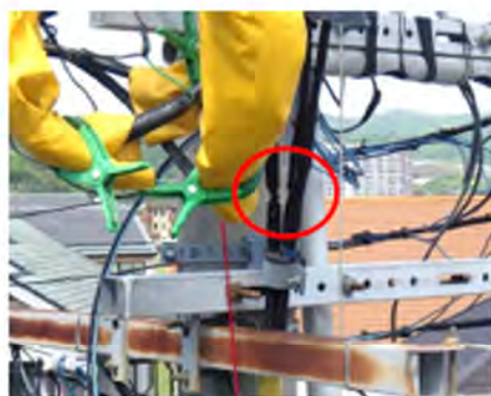
写真2 事故ケーブルの設置状況
