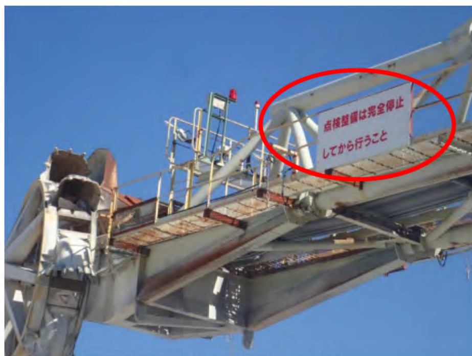
写真3 対策2（注意標識の設置）
