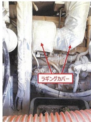
写真5 ラギングカバー取付け状態
