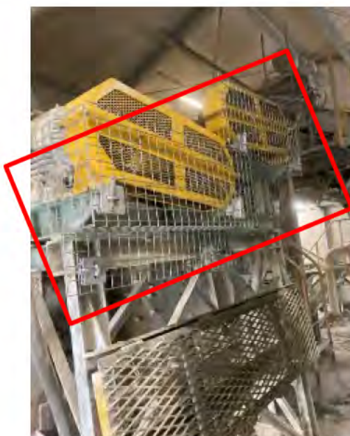
写真5 保安柵（赤枠）設置後
