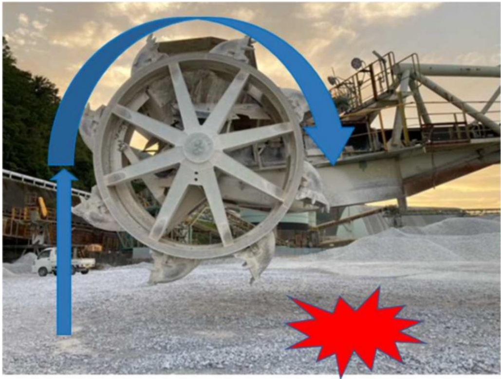
写真：罹災状況（赤印の箇所に墜落）
